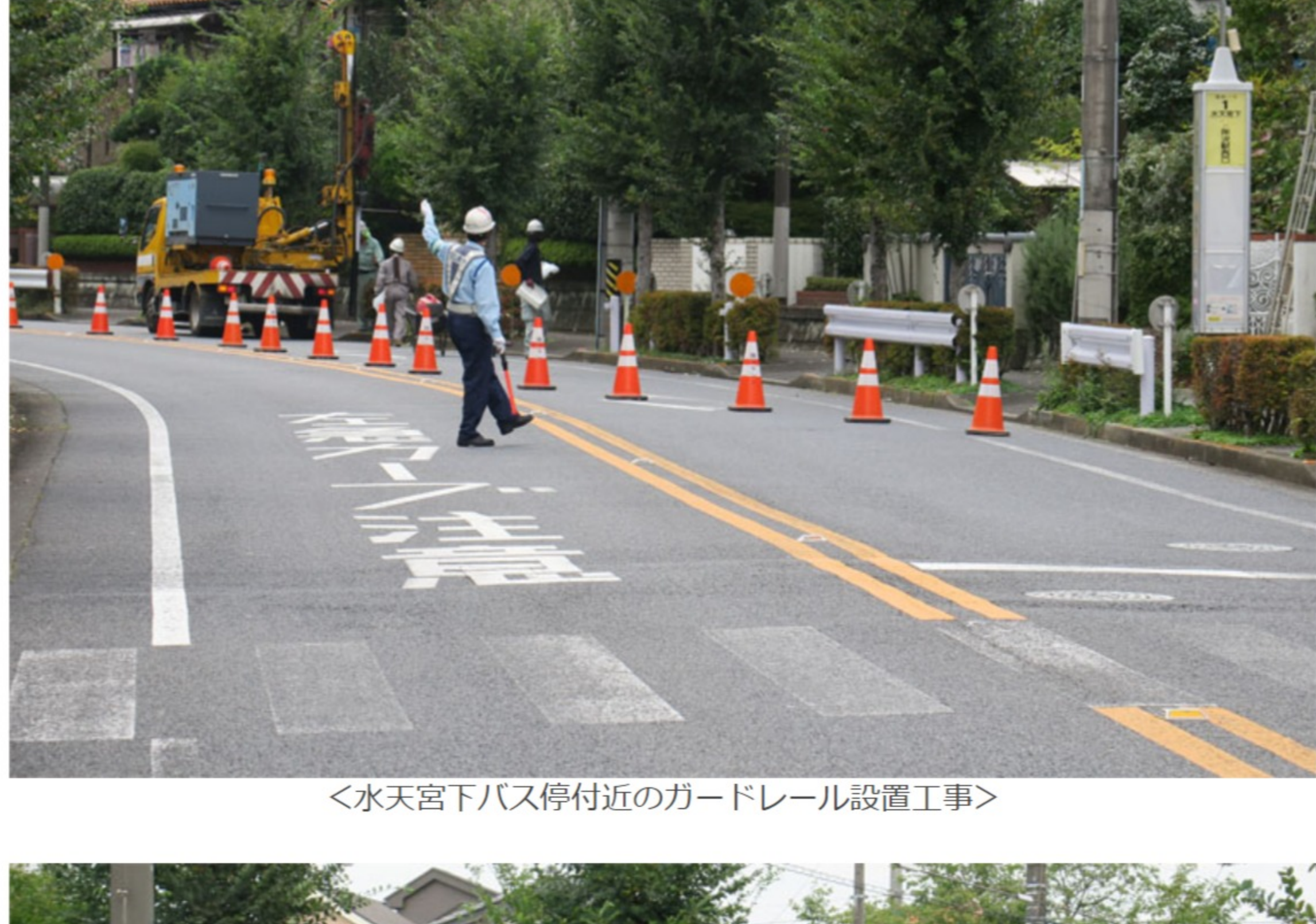
<水天宮下バス停付近のガードレール設置工事>
