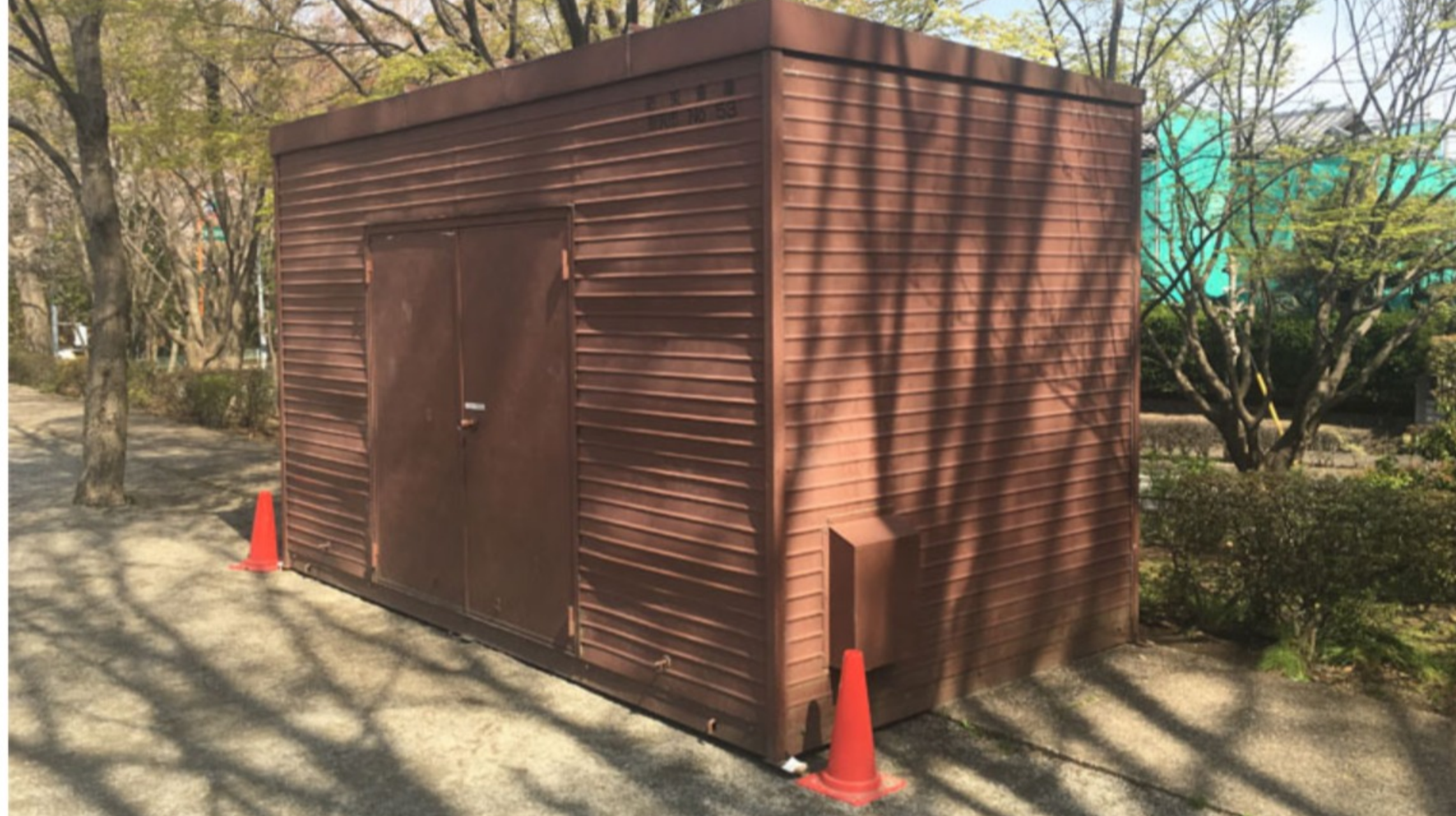
<撤去された古い防災備蓄倉庫>
