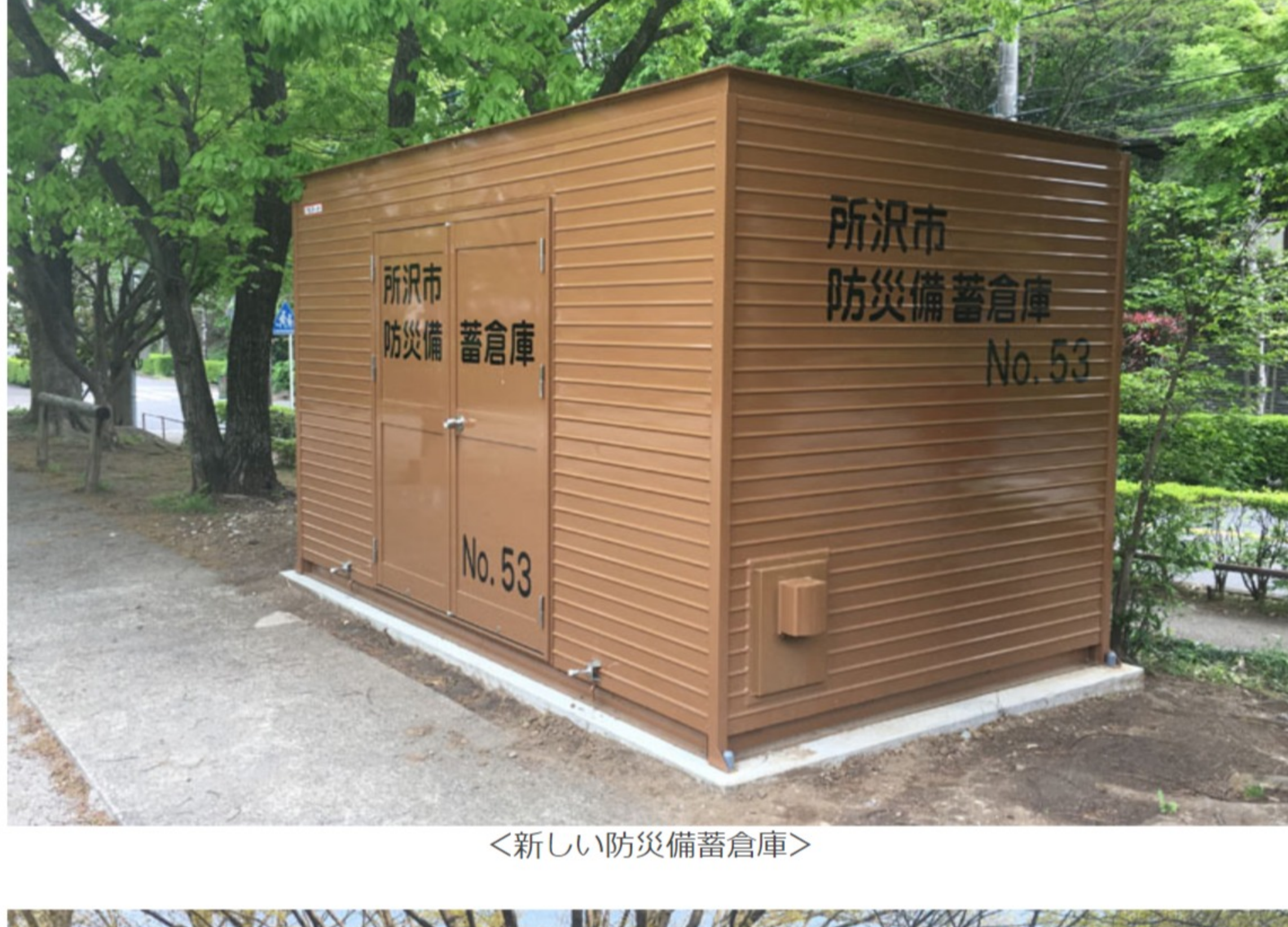
<新しい防災備蓄倉庫>
